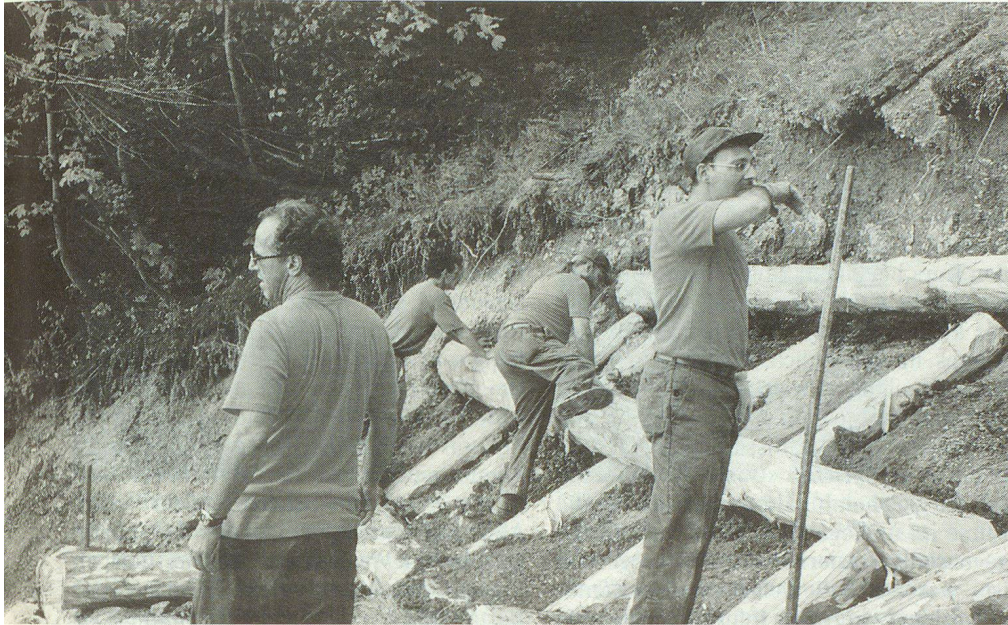
Eine Hangrutschung wird mit massiven Baumstämmen gesichert.
