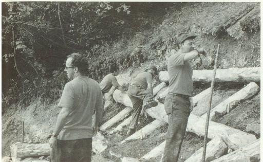
Eine Hangrutschung wird mit massiven Baumstämmen gesichert.
