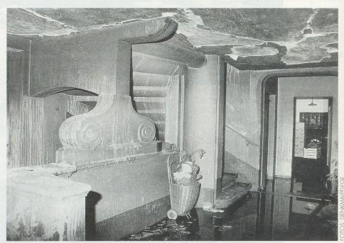
Verrusstes Treppenhaus mit Löschwasserschäden.
