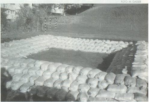
Das innen  $5,60 \times 5,60$  m messende Löschwasserbecken aus Sandsäcken.
