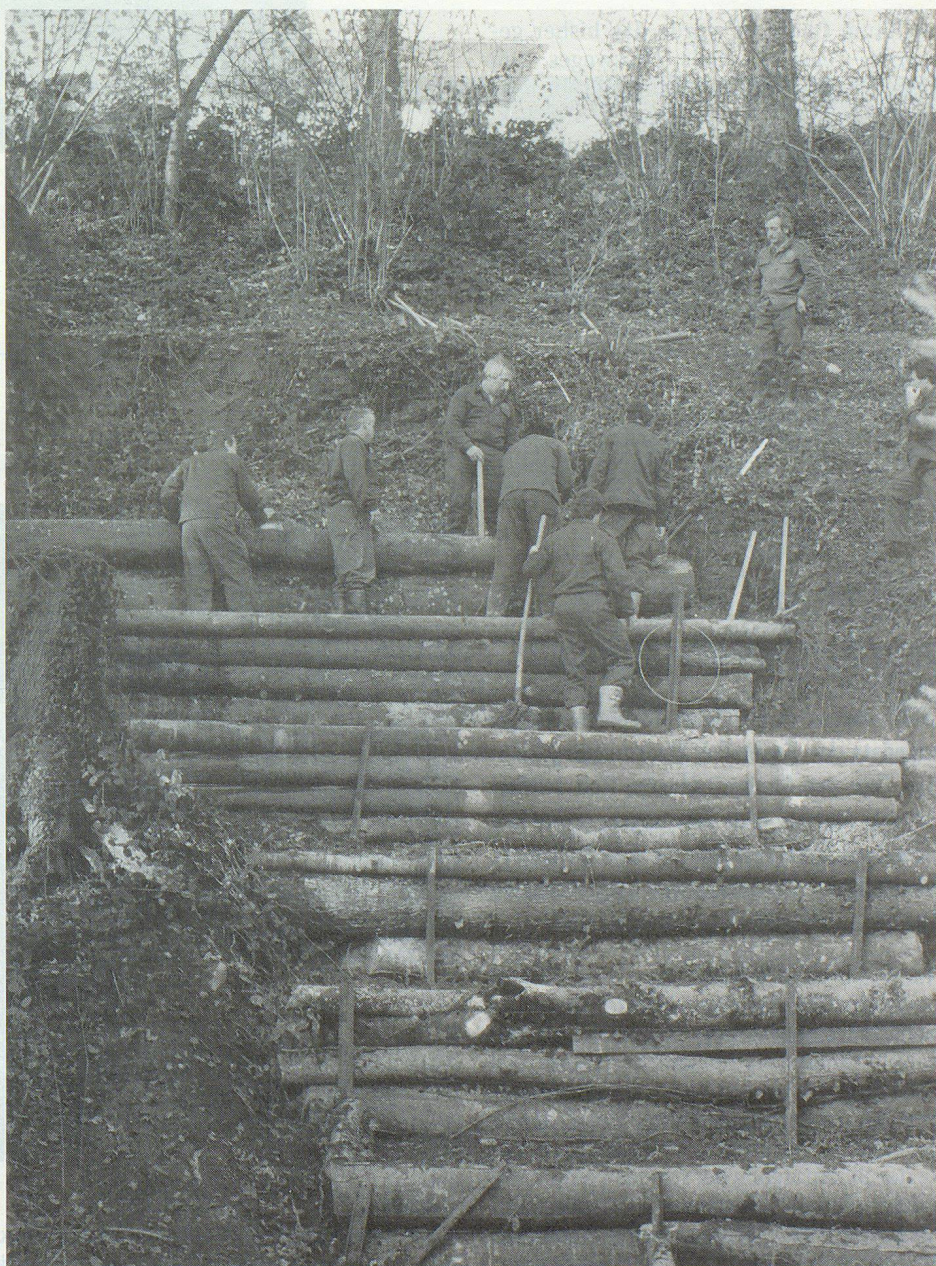
Massive Verbauung eines abgerutschten Hanges in Häggenschwil.
