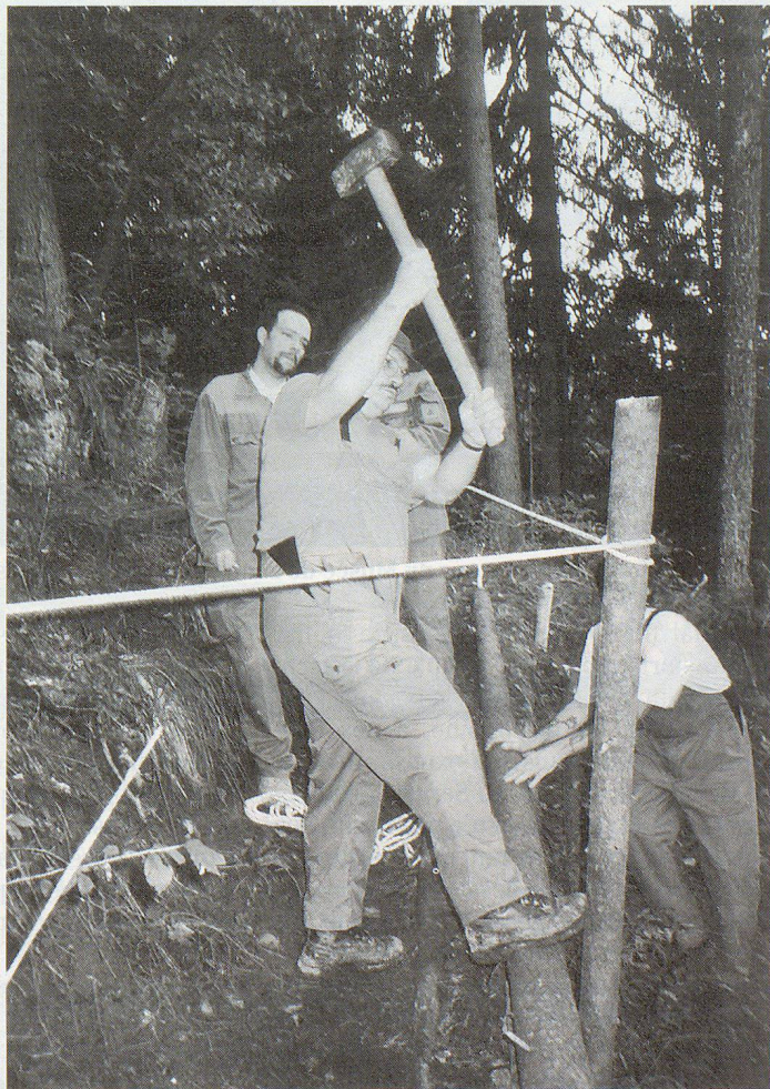
... pose des rondins et consolidation du chemin.
