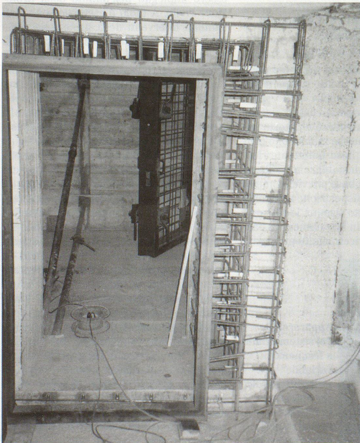
Nachträglicher Einbau einer Panzertüre.
