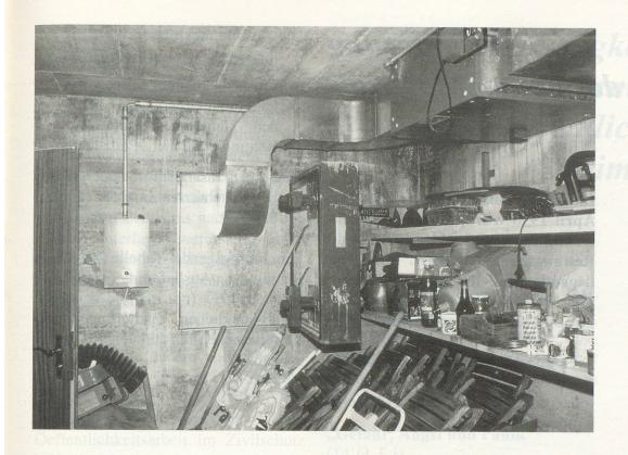
Bild: Die Schutzraumkontrolle erfolgte leider zu spät. Wie unschwer zu erkennen ist, wurde der Schutzraum baulich derart verändert, dass er nicht annähernd mehr den Anforderungen entspricht.
