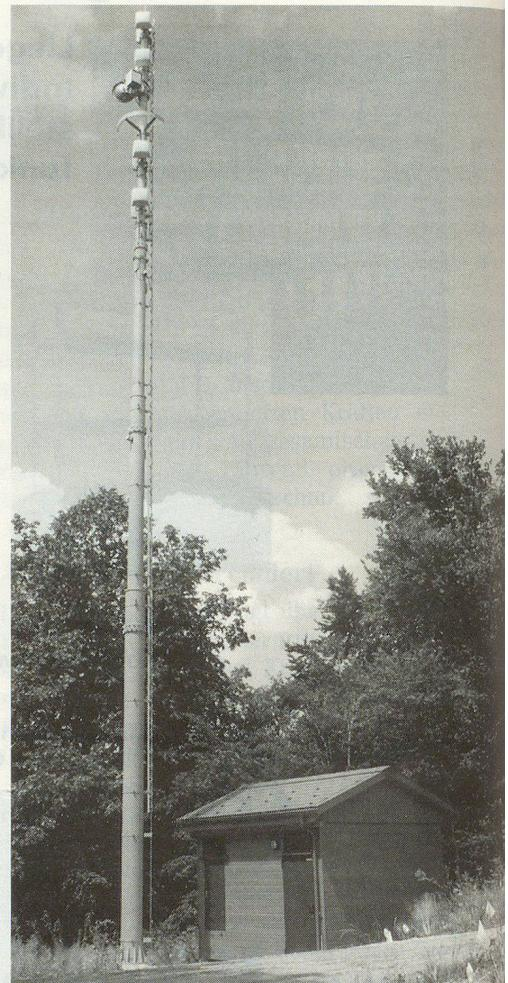
**Une des quelque 1500 stations de base qui permettent l'utilisation du Natel D en Suisse. La station de base de Densbüren AG couvre une zone de 5 à 7 kilomètres de diamètre.**
