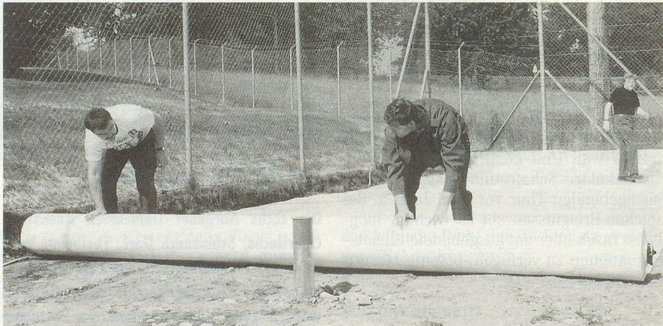
Ausmessen, zuschneiden und auslegen der Folie vor dem Verteilen des Quarzsandes.
