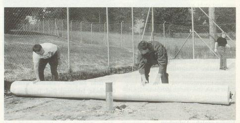
Ausmessen. zuschneiden und auslegen der Folie vor dem Verteilen des Quarzsandes.
