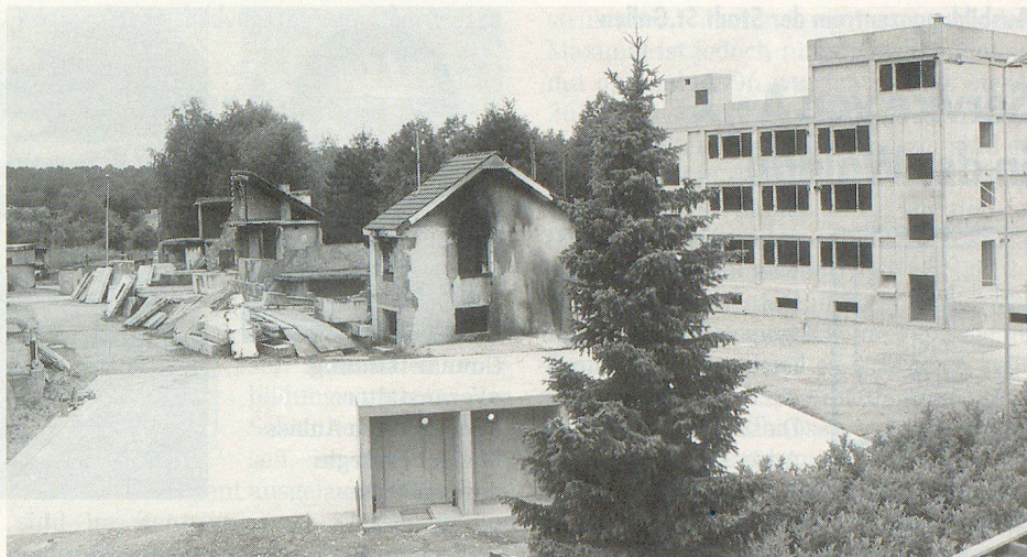
Blick auf das neue Brandhaus und die Brandwanne.
