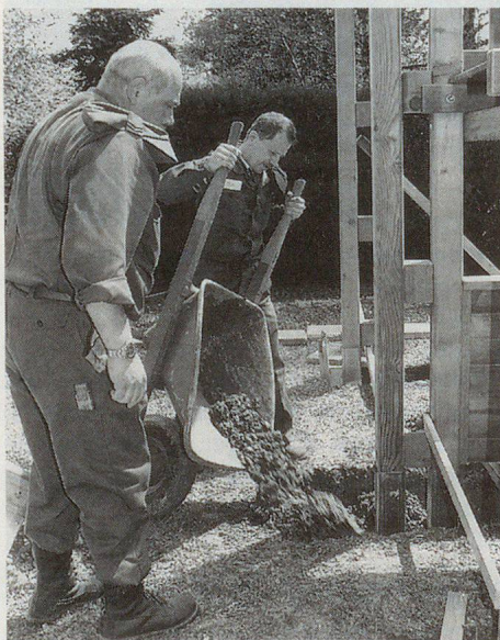
On coule la première brouette de béton.
