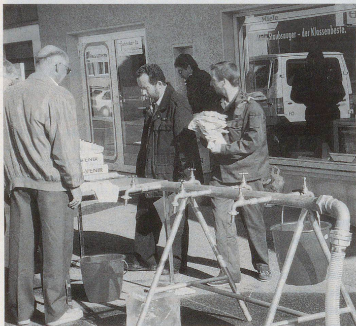
Notzapfstelle nach dem Hol-Prinzip.
