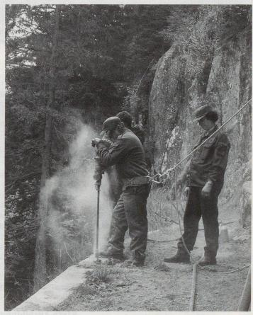
Einsatz der Pressluftgeräte in anspruchsvollem Gelände.
