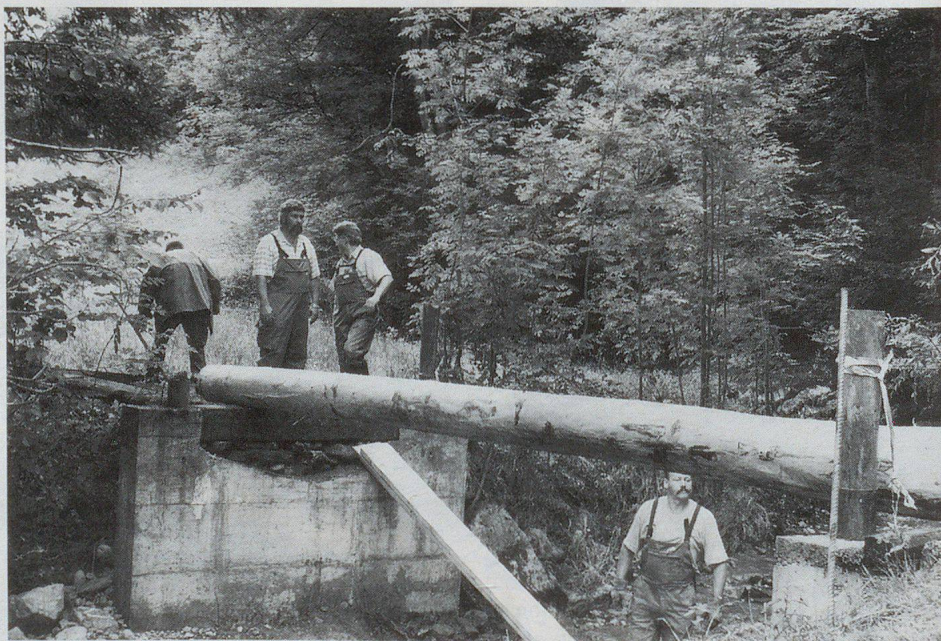
Zivilschützer erstellen eine massive Holzbrücke.
