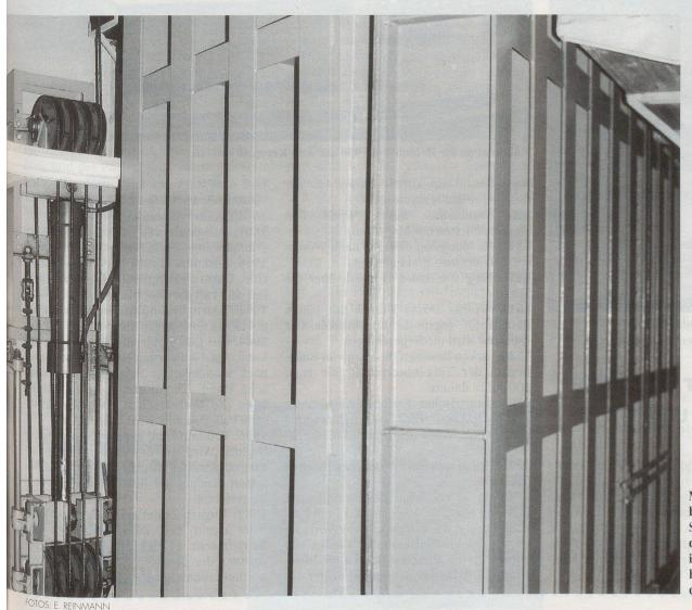
Mit hydraulisch betriebenen Stahltoren können die Schutzanlagen innert Minuten hermetisch abgedichtet werden.
