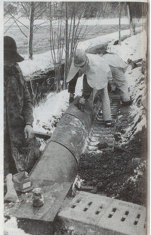
Über 300 Meter Leitwände und Amphibientunnel wurden verlegt.
