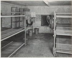
Abri privé ou obligatoire de 18 places protégées avec couchettes démontables, étagères, appareil de ventilation, bidons de toilettes à sec et sortie de secours.
