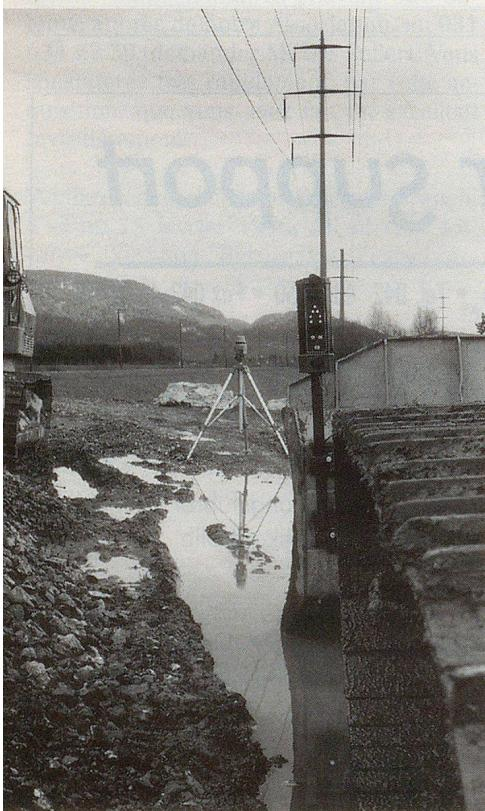
Mit Hilfe des Laserempfängers MCR 12 kann der Baumaschinenführer die Schubhöhe schnell und sicher einstellen.
