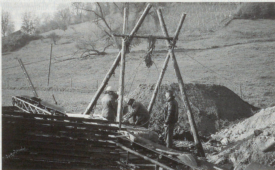
So einfach hebt und verschiebt der Zivilschutz schwere Lasten.
