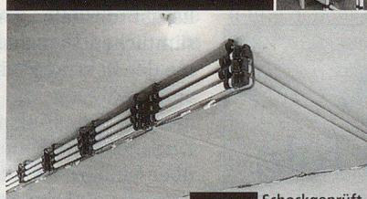
**Vormontierte Lagerung an der Schutzraumdecke**
