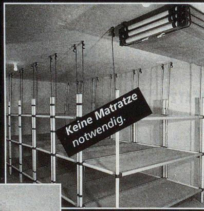
Vormontierte Lagerung an der Schutzraumdecke
