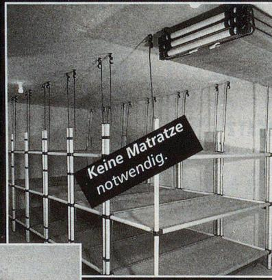
**Vormontierte Lagerung an der Schutzraumdecke**
