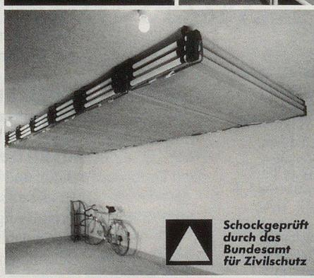
Vormontierte Lagerung an der Schutzaumdecke
