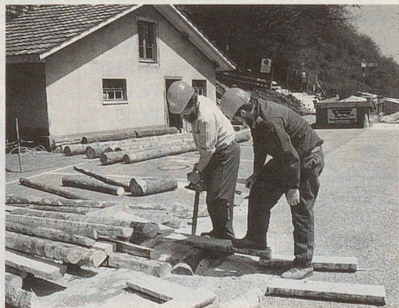
Dank guter Vorbereitungsritten die Arbeiten rasch voran.
