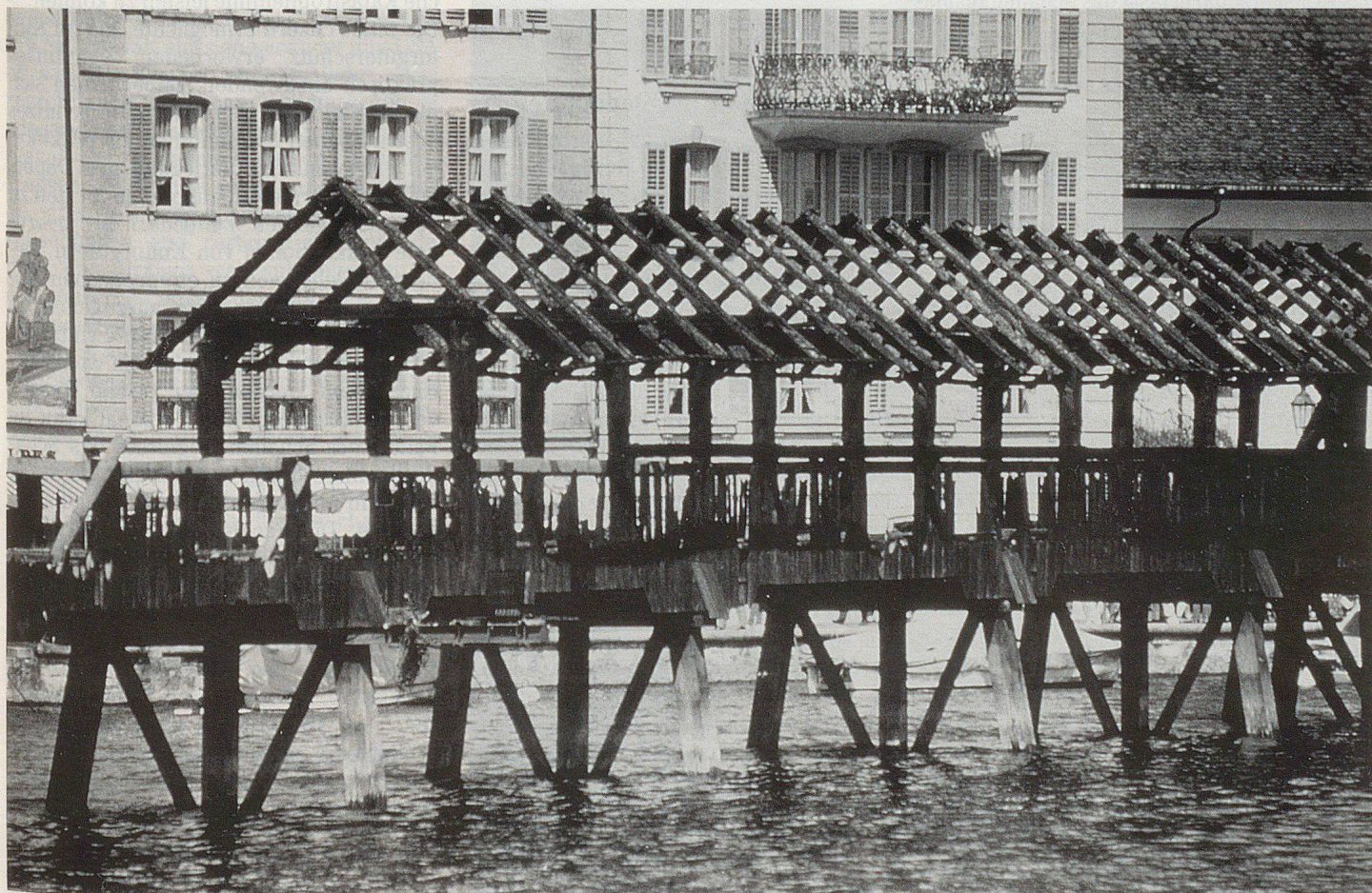
Die Kapellbrücke nach dem Brand.
