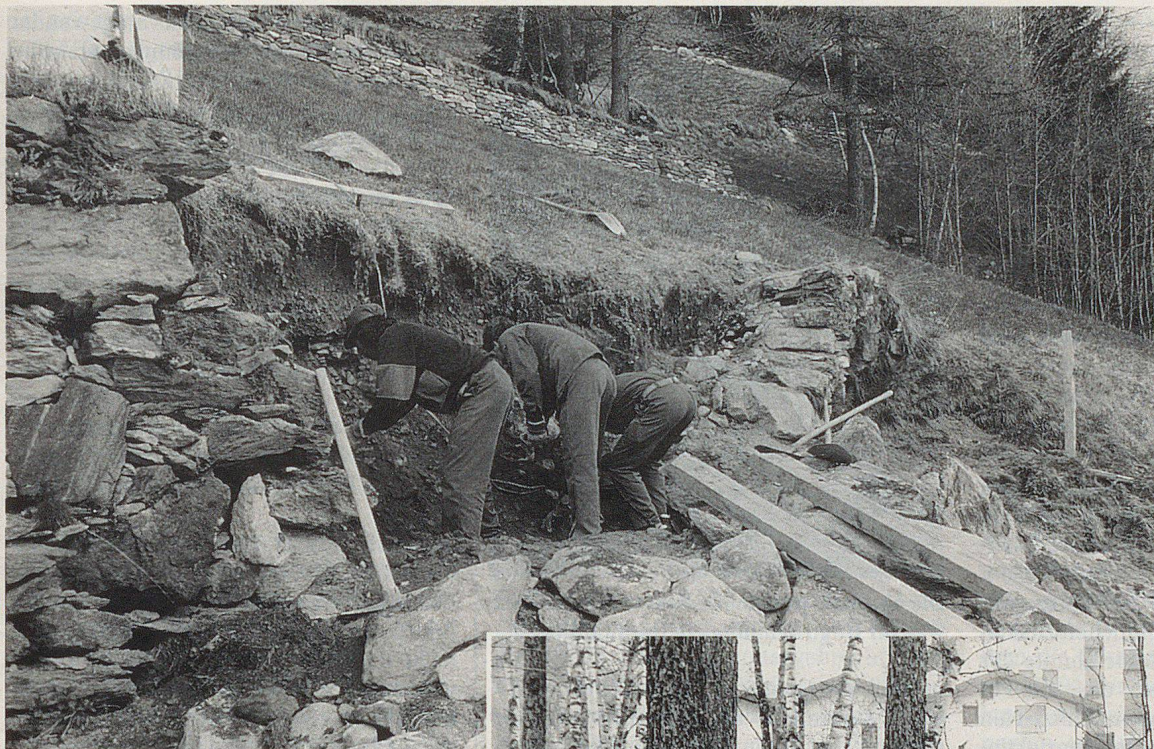
Eine teilweise zerstörte Trockensteinmauer wird instandgestellt.
