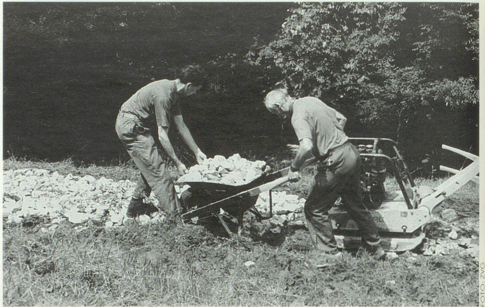
Zivilschützer bei der Sanierung eines Fussweges.
