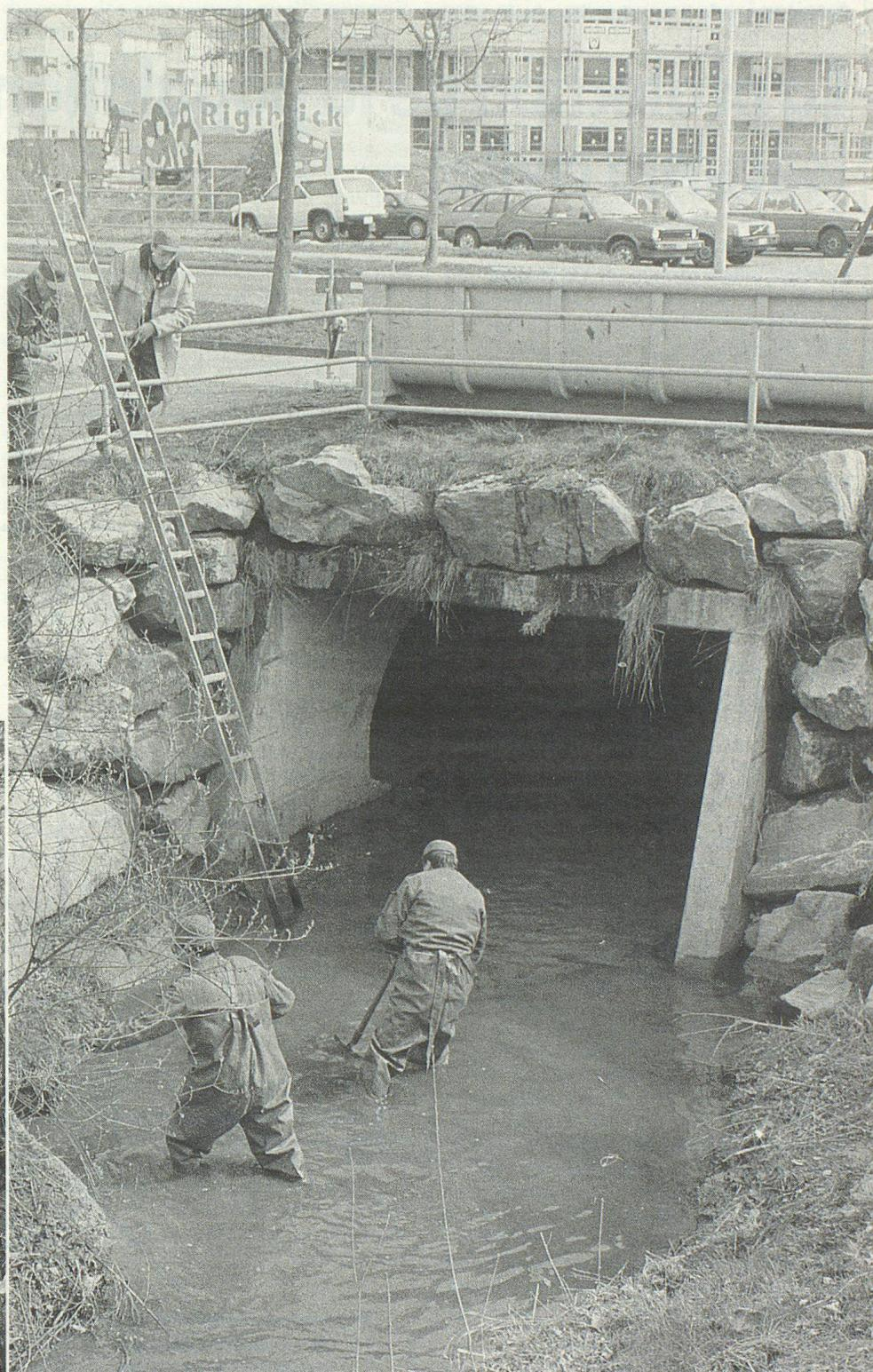
**Mit der Verbreiterung des Auslaufkanals sorgte der Zivilschutz dafür, dass die Überschwemmungsgefahr gebannt ist.**
