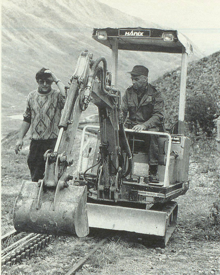
Der Bauchef der DFB liess auch leichte Baumaschinen einsetzen.
