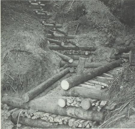
Der Schwellenbau bricht die Wucht des Wassers und verhindert weitere Erosionen.
