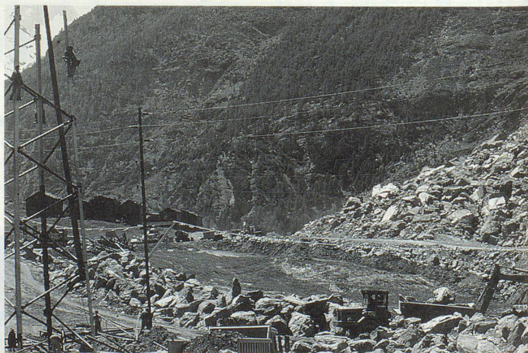
Reconstruction des lignes électriques aériennes.
