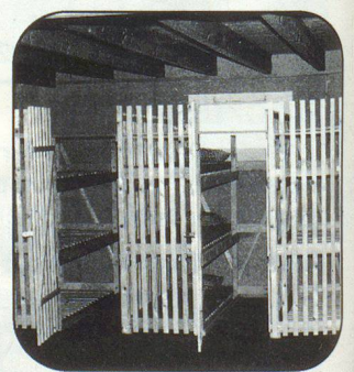
Kellerverschläge aus Schutzraumliegen BK 86
