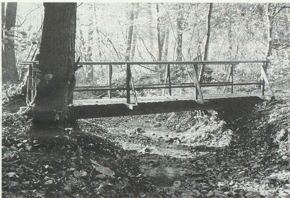
Über den Wasserlauf wurde aus Schadenplatzmaterial eine neue Brücke gebaut.
