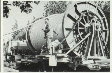
Um die Stromversorgung des SRK-Zentrums, des Paraplegikerzentrums und des Militärspitals zu gewährleisten, wurde ein über 2 Kilometer langes Unterwasserkabel durch den Sempachersee von Schenkon nach Nottwil verlegt.
