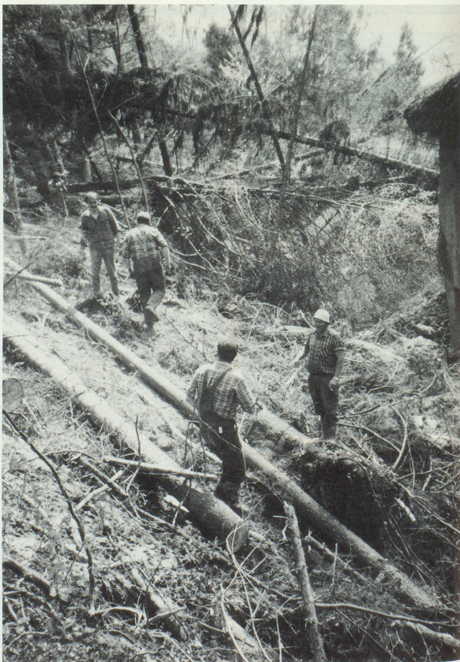
Arbeitsorientierung durch den Förster.
