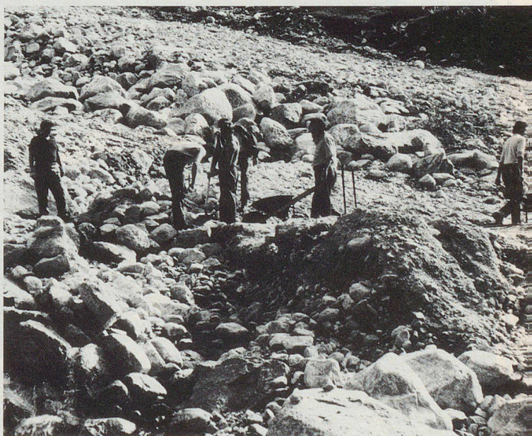
Der vom Unwetter ausgespülte Winterweg zur Göscheneralp wird saniert.
