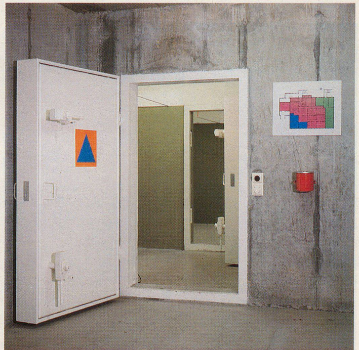
Illustrazione 5 Gli impianti di protezione indicati nell'illustrazione 4 vengono ulteriormente designati con il segno distintivo della protezione civile (di carta, 30x30 cm) posto all'interno e all'esterno sulla/e porta/e blindata/e (o sulla porta d'ingresso dei rifugi e impianti di fortuna), cifra 231, cpv. 1 e 3.
