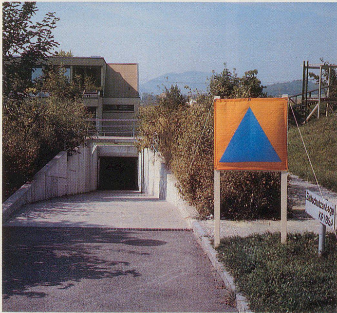
Abbildung 4 Aussenkennzeichnung (mögliche Beispiele) von Einzelanlagen (KP, BSA) der Schutzorganisationen und von öffentlichen Schutzräumen sowie von Kombinationsbauten der genannten Schutzbauten ohne sanitätsdienstliche Anlagen. Ziffer 232, Abs. 2 und 3. Zivilschutzzeichen aus Textilmaterial 80x80 cm.
