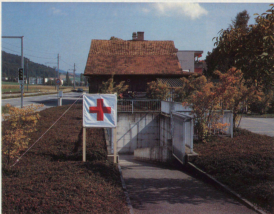
Abbildung 6 Aussenkennzeichnung (mögliche Beispiele) von Einzelanlagen des Sanitätsdienstes oder – bei Kombinationsanlagen – des separaten Eingangs zur sanitätsdienstlichen Anlage, Ziffer 232 Abs. 4. Rot-Kreuz-Schutzzeichen aus Textilmaterial 80x80 cm.
