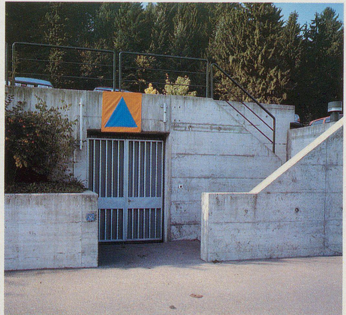
Illustrazione 4 Designazione esterna (esempi possibili) di impianti singoli (PC, IAP) degli organismi di protezione e dei rifugi pubblici nonché di impianti combinati, cifra 232, cpv. 2 e 3. Segno distintivo della protezione civile in materiale tessile, 80x80 cm.
