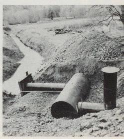
Stahltank-SR in der Baugrube. Links das horizontale Eingangsrohr.
