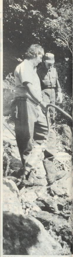
Mit Bohrhammer werden die grössten Steinbrocken zerkleinert, damit sie für eine Bachverbauung verwendet werden können.
