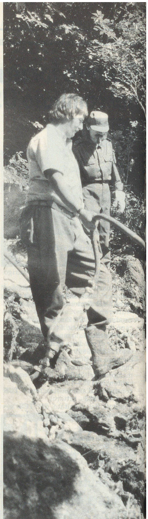
Mit Bohrhämmer werden die grössten Steinbrocken zerkleinert, damit sie für eine Bachverbauung verwendet werden können.
