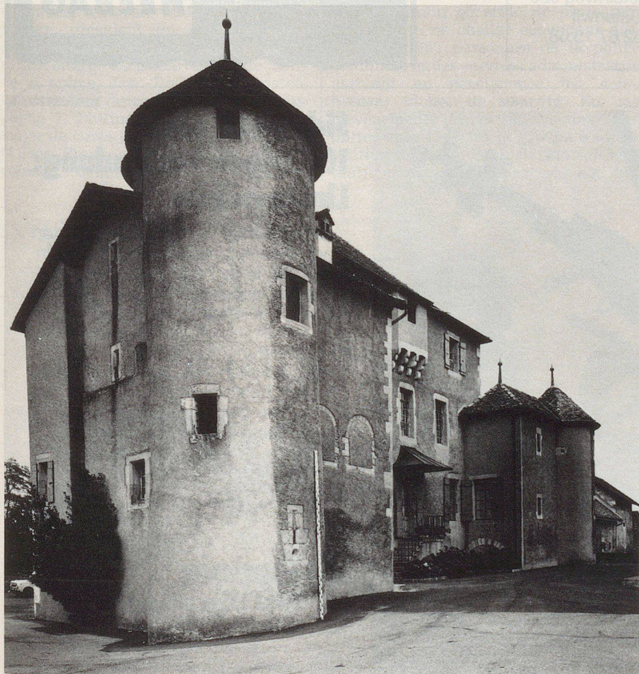
La commanderie de Compiègne, dans la commune de Bardonnex GE: l'un des 263 monuments du canton à protéger.
