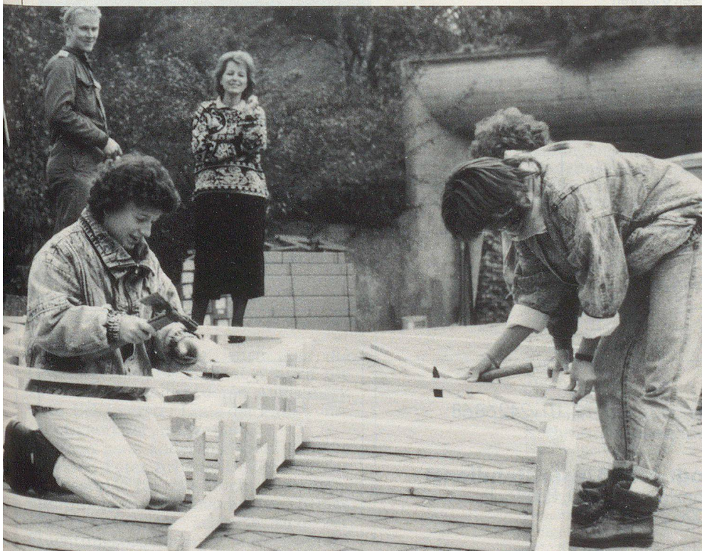
Unter Anleitung eines jungen Schutzraumchefs wird ein «Doppelgestell» fertiggestellt.
