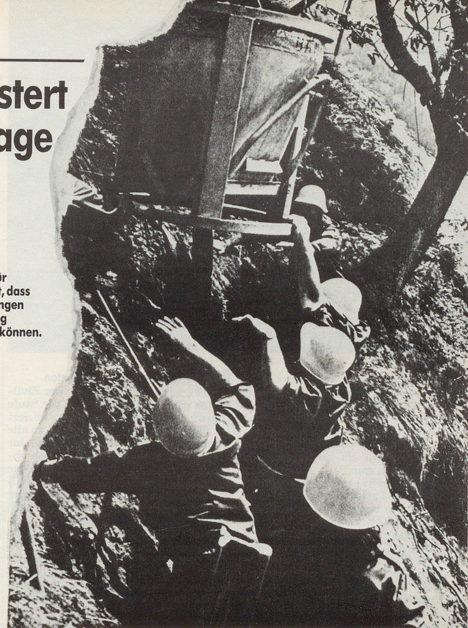
Betonkübel sind im dauernden Anflug, die ZS-Männer erwarten den Beton aus der Höhe, greifen den am langen Seil pendelnden Kübel und schütten den Inhalt in die Grube.
