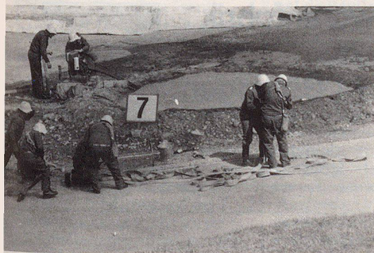
Inmitten des Schadengebiets wird ein Wasserbecken aufgestellt, um mit den löschenden Strahlen näher an die Objekte heranzukommen.
