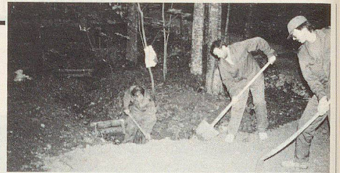
Im Vordergrund Verteilung des Wegbelages, im Hintergrund Bachstaungen.
