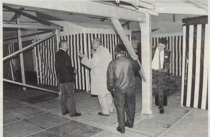
Der Prototyp des neuen Universalgestells der Holzbau Wirth AG, Schwanden. Links in der Mitte ist eine Liege umgedreht worden, wie sie für eine Kellerhürde oder ein Lagergestell verwendet werden kann.
