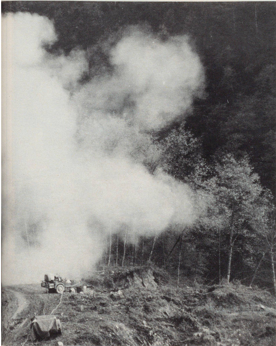
Soeben erfolgte eine Sprengung von wegversperrenden Felsbrocken.
