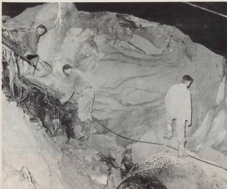
Soeben erfolgte eine Sprengung von wegversperrenden Felsbrocken.
