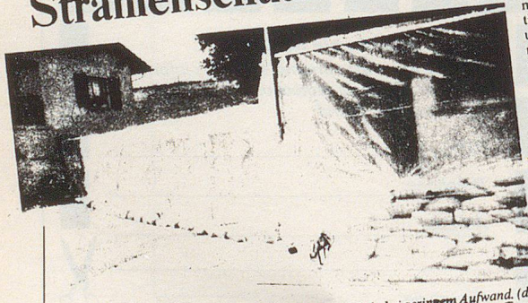
Sandsäcke und Plastikfolie ergaben einen hohen Schutzeffekt bei geringem Aufwand. (di)
