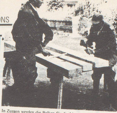
In Zuzgen werden die Balken für die Liegen vorbereitet.
