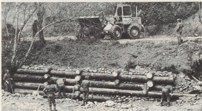
Flussuferverbauung an der Zulg.
