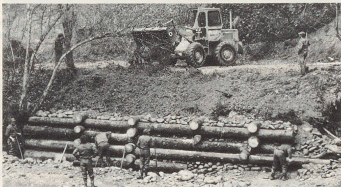
Flussuferverbauung an der Zulg.
