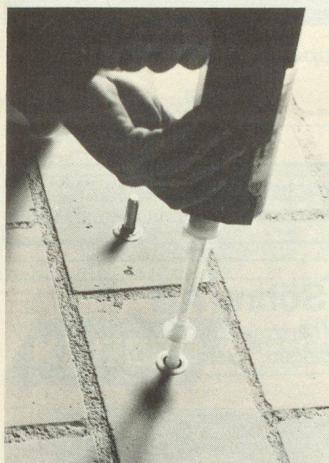
den mit gewissen Unsicherheitsfaktoren, zu bewältigen. Mit dem neuen HIT-System von Hilti werden nun solche Befestigungsprobleme einfach «wegenjiziert»: Loch bohren, verfüllen, Befestigungselement eindrücken, fertig! Und das erst noch formschlüssig und spreizdruckfrei. Das HIT-System ist eine kompakte Sache. Man
